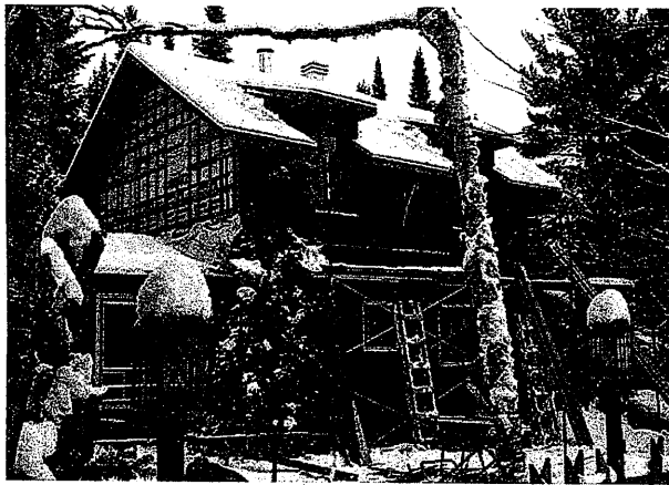
La maison durant les travaux, l'hiver dernier.
